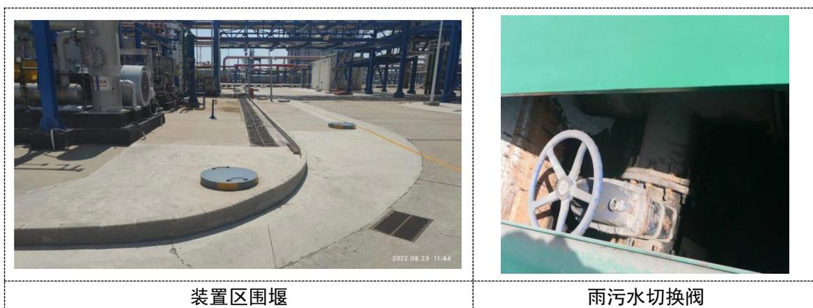
图 3.17 聚丙烯装置区事故水一级防线
