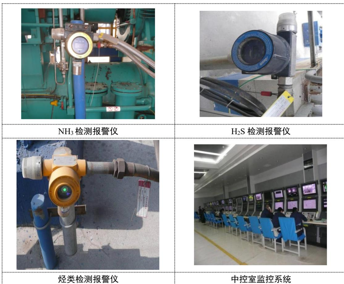
图 3.16 有毒/可燃气体检测报警仪、中控室监控系统图
