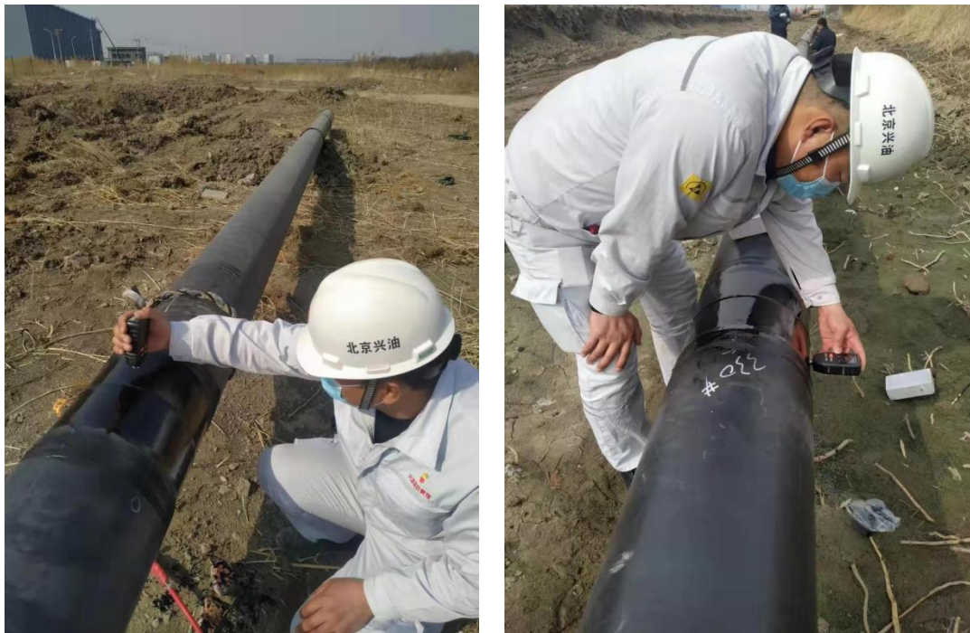
图 4-4 管道防腐措施照片
