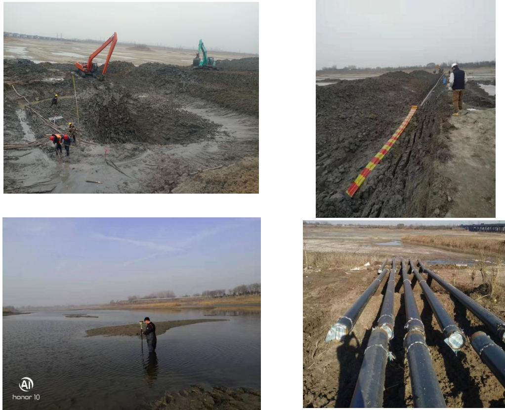
图 4-3 水塘开挖沉管施工照片
