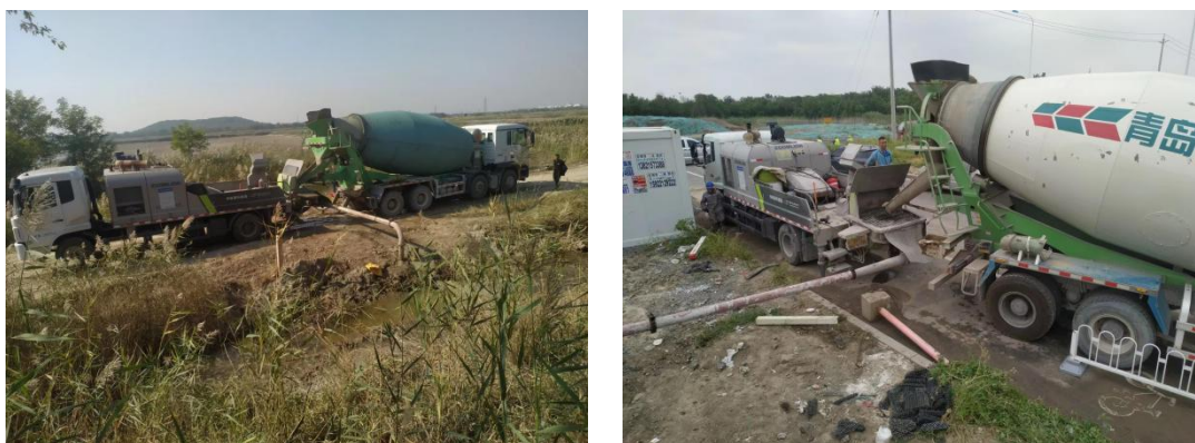
图 4-8 注浆作业现场照片
