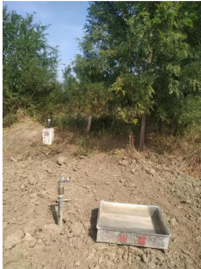
图 4-9 注浆作业接收槽
