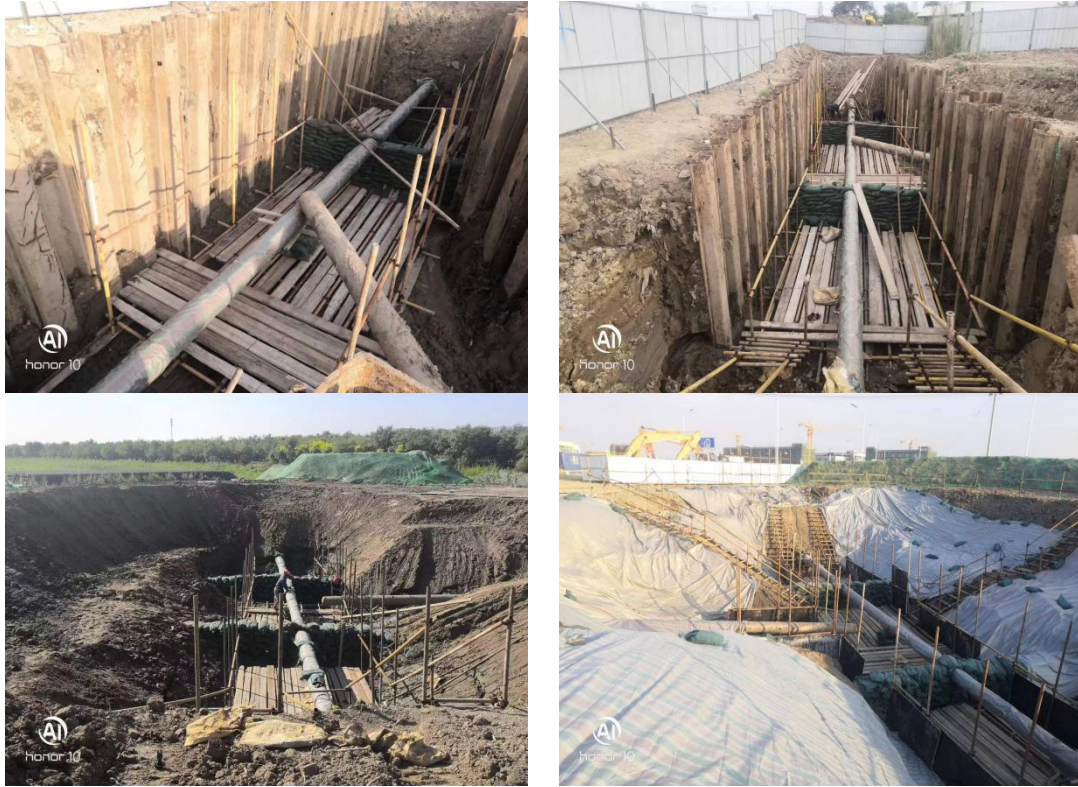
图 4-2 施工作业井照片
