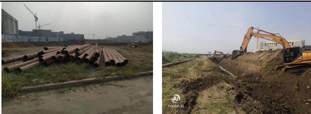
图 4-6 旧管道拆除开挖施工过程照片
