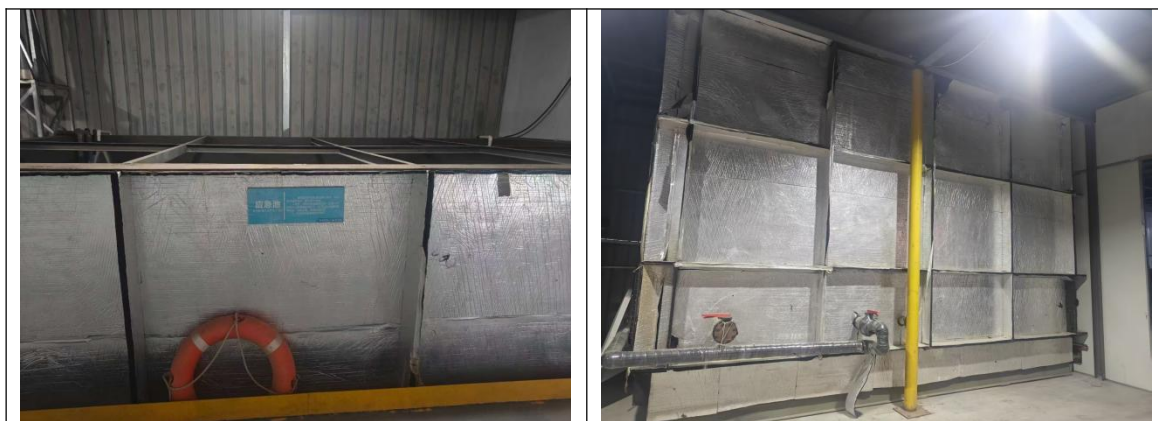
图 3-4 事故应急池照片
