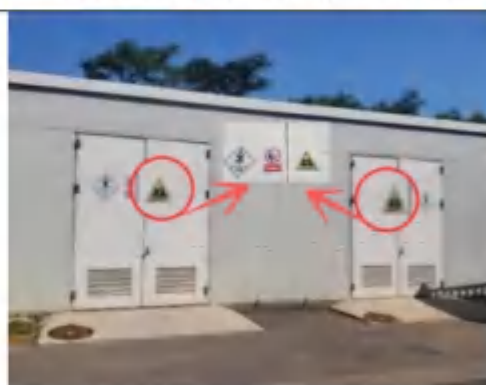
危险废物暂存间（2#）规范化照片
