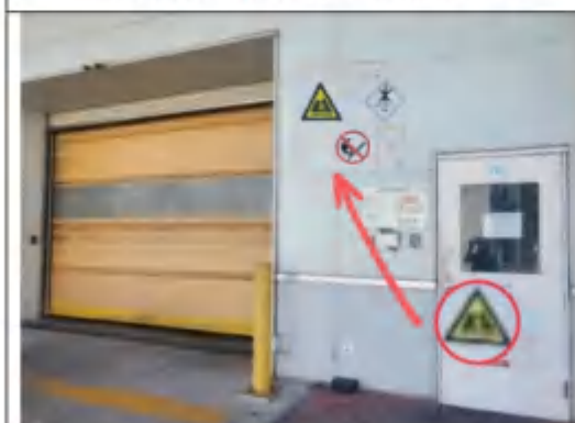
危险废物暂存间（1#）规范化照片
