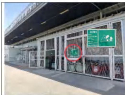
一般固废暂存间（1#）规范化照片
